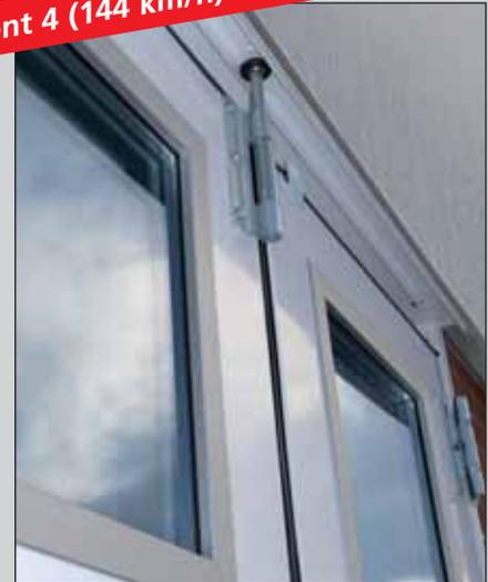
La nouvelle technique de guidage est convaincante par sa facilité d'utilisation, le fonctionnement silencieux de la porte et donc son usure minimale.
